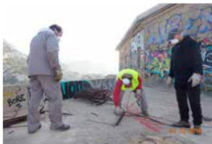
L'association Evolio sur le chantier
